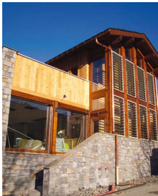
Straordinariamente bello: l'asilo nido di Saint Martin de Belleville ha un consumo di energia minimo.
