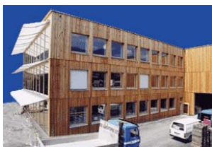
Figura 3: In questo edificio per uffici a Coira/CH lavorano circa 30 persone che non hanno mai patito il freddo, nonostante l’assenza di un impianto di riscaldamento convenzionale.
