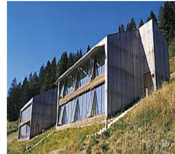
Figura 1: La casa a guadagno diretto di Trin/CH è a 900 metri di altezza e se la cava bene anche senza riscaldamento e impianto di ventilazione.
