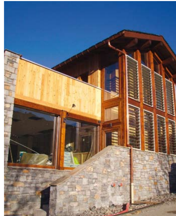
Auffällig schön: Die Kindertagesstätte von Saint Martin de Belleville kommt mit minimaler Heizenergie aus.
