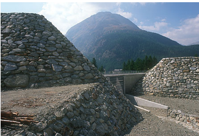
Auffangdamm oberhalb von Pontresina/Engadin; er wurde notwendig weil das Dauerfrostgebiet oberhalb der Stadt zu schmelzen begann. Kosten: 5 Millionen Euro. (Foto: GÖF)
